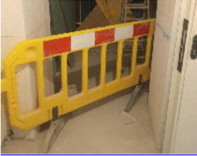
Debido a los avances de los trabajos de montaje de ascensor, PECSA (cumpliendo con sus obligaciones como contratista) ha colocado protecciones colectivas en las embocaduras de los huecos de ascensor de plantas 3º, 4º, 5º y, en el punto de paso de personal de ATENEO en planta 3º, se ha colocado una valla que impide acercarse incluso a las protecciones del hueco ([como se ve en las fotos](#)). ([Seguir leyendo](#))
